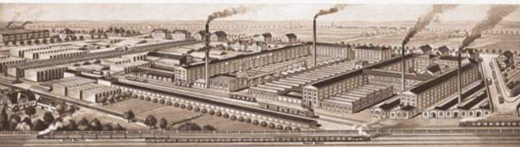
Ansicht des Werkes Gütersloh
