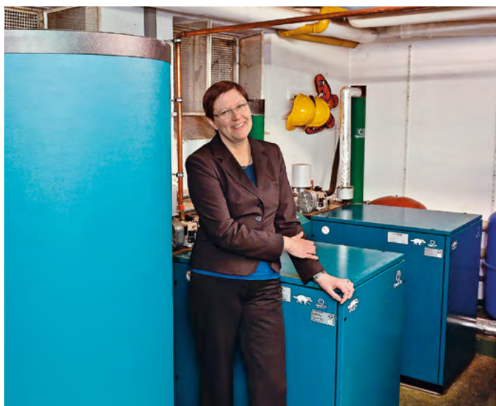
Katrin Wahl-Harms ist froh, dass sie ihr Blockheizkraftwerk auch im Sommer nutzen kann. Dafür sorgt der neue Trockner, dessen Prozessluft regelmäßig über das heiße Wasser aus dem BHKW erwärmt wird.
